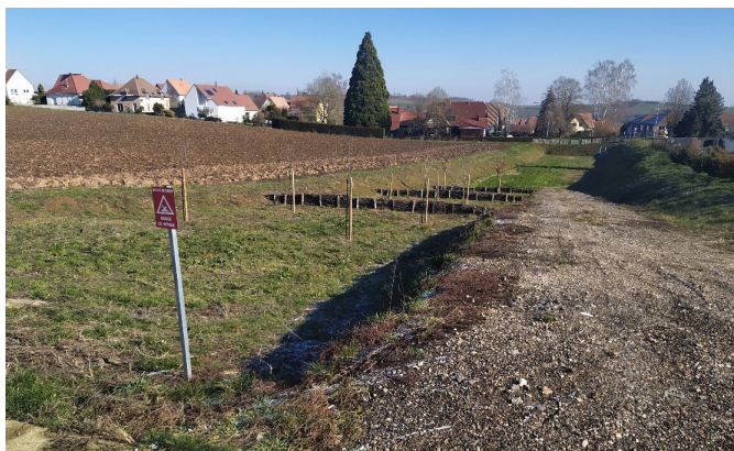
Bassin de rétention de Kienheim et fascines
