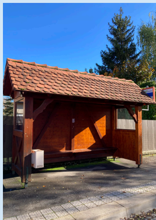
Abri-bus à Reitwiller
